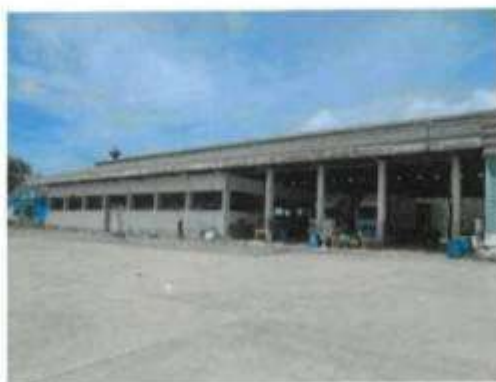
สภาพอาคารแปรรูปชิ้นเดียว (รายการที่ 5)
