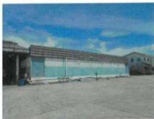
สภาพอาคารแปรรูปชิ้นเดียว (รายการที่ 4)
