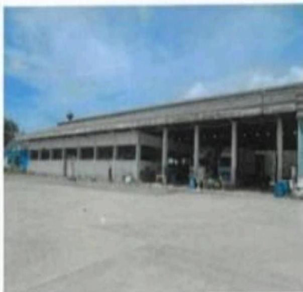
สภาพอาคารแปรรูปขึ้นเดียว (รายการที่ 5)
