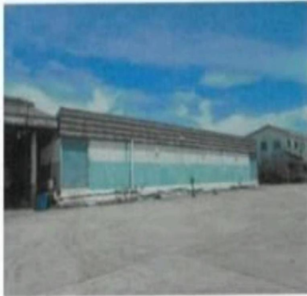
สภาพอาคารแปรรูปขึ้นเดียว (รายการที่ 4)
